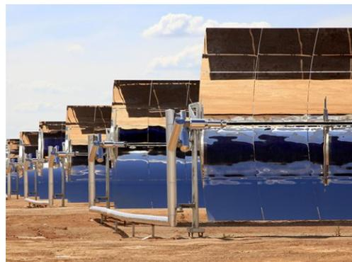
solar propio y un accionamiento hidráulico que permite orientar los espejos según la trayectoria del sol.
