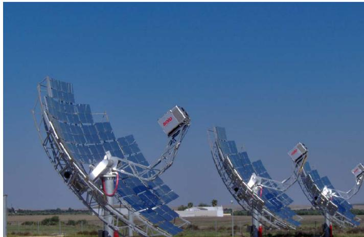
**Figura 68** Disco Stirling en la Plataforma Solar de Solúcar (Abengoa Solar).
