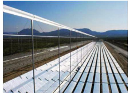
**Figura 67.-** Puerto Errado 1, primera planta termosolar de espejos planos fresnel.
