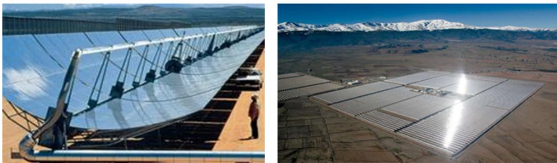
**Figura 59** Fotos de Andasol 1. El Grupo ACS, a través de Cobra Energía, empresa integrada en su área de Servicios Industriales, ha invertido en Andasol-1 (Aldeire, Granada) un total de 300 millones de euros<sup>31</sup>, siendo esta la primera planta termosolar de Cilindro parabólico instalado en el mundo con almacenamiento de energía mediante sales fundidas, que le permite operar cuando no hay radiación solar (un tiempo limitado de no más de 7 horas).
