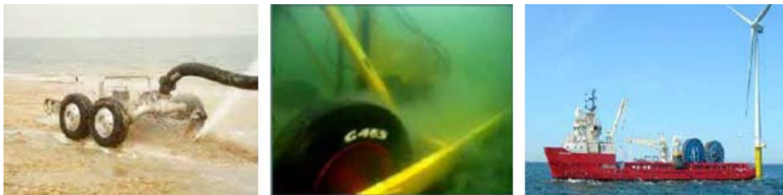
Figura 55.- Diferentes partes del proceso de tendido de cable eléctrico.
