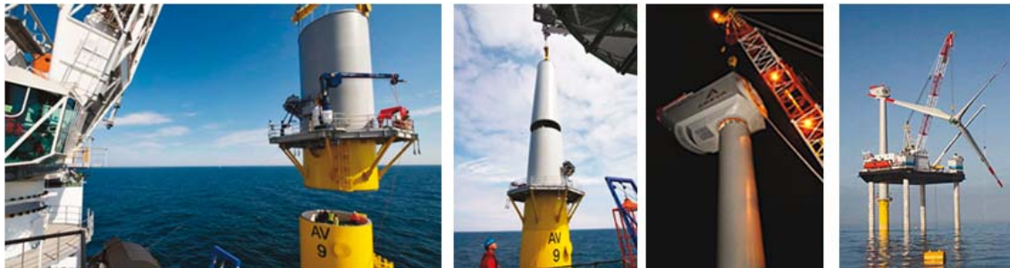
Figura 54.- Diferentes partes del proceso de instalación de las torres, góndolas y álabes (Areba Corporate Website).
