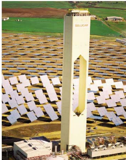
Figura 66.- Torre de la Plataforma Solar PS10, en Sanlúcar la Mayor (Abengoa Solar).
