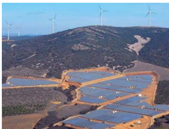
Figura 38.- Parque Fotovoltaico de Puertollano, puesto en funcionamiento a finales de 2009 es el mas grande construido hasta la fecha.
