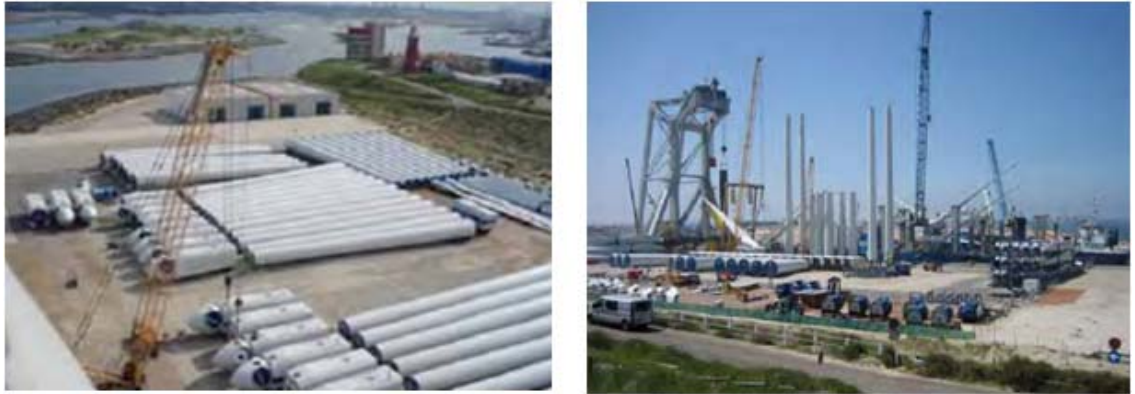
Figura 52.- Puerto acondicionado para el montaje de un parque eólico offshore (Vestas).
